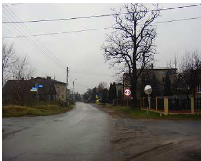
Trwa przebudowa jezdni przy ul. Wolności w ramach NPPDL (tzw. schetynówki), bu- dowa chodnika oraz kanalizacji deszczo- wej. Koszt inwestycji 6 mln zł.
