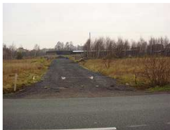
Budowa nowej drogi nr 6.
