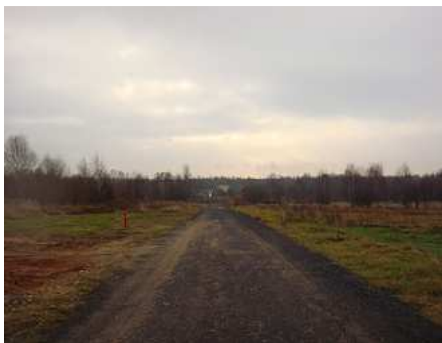
Budowa drogi i wodociągu przy ul. Jeziornej.
