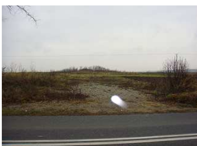
Trwają prace nad projektem nowej drogi nr 2.
