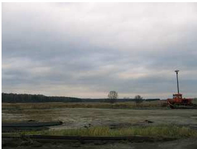
Rekultywacja terenu pod przyszłe boisko i tereny urządzonej zieleni.
