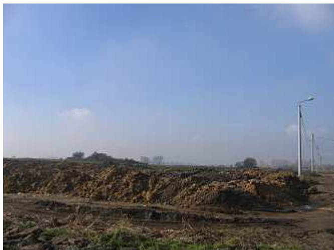
Rekultywacja kamionki pod przyszłe boisko.
