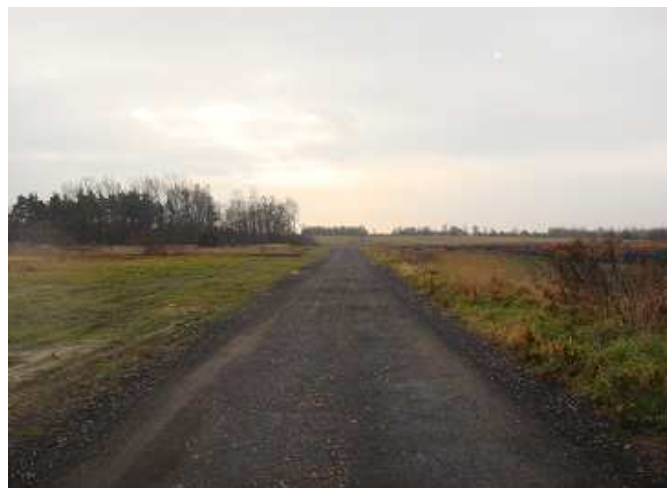
Utwardzono nawierzchnię ul. Zawadzkiego w kierunku Oss i wybudowano sieć wodociagową.
