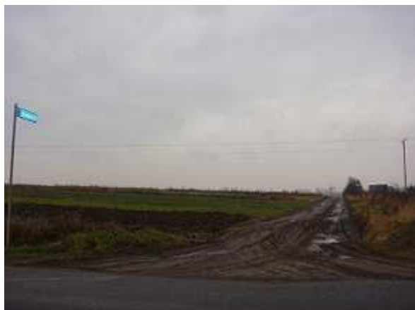
Ul. Kamienna (nr 3) zniszczona podczas budowy autostrady.
