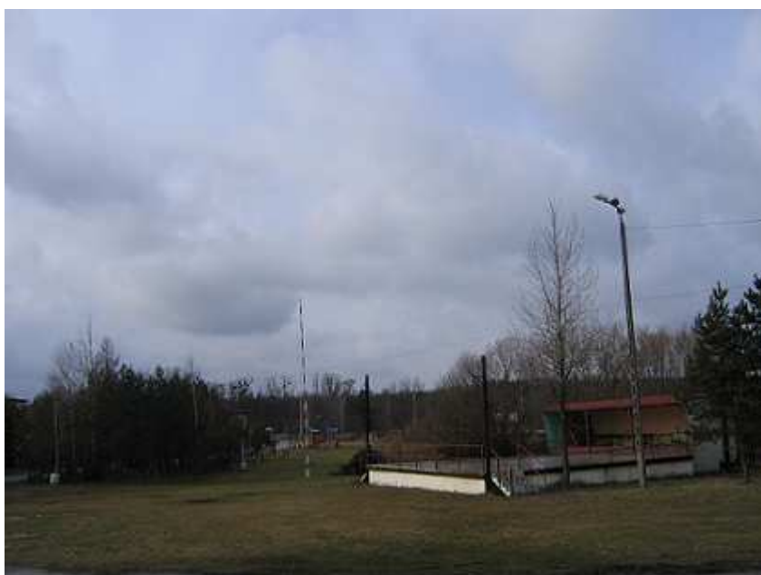
Trwa budowa amfiteatru z telebimem na Placu Floriana. W ramach programu PROW Niezdara otrzymała dotację z UE. Razem ze środkami gminy to 1,1 mln zł. Zadanie będzie ukończone w czerwcu 2011.
