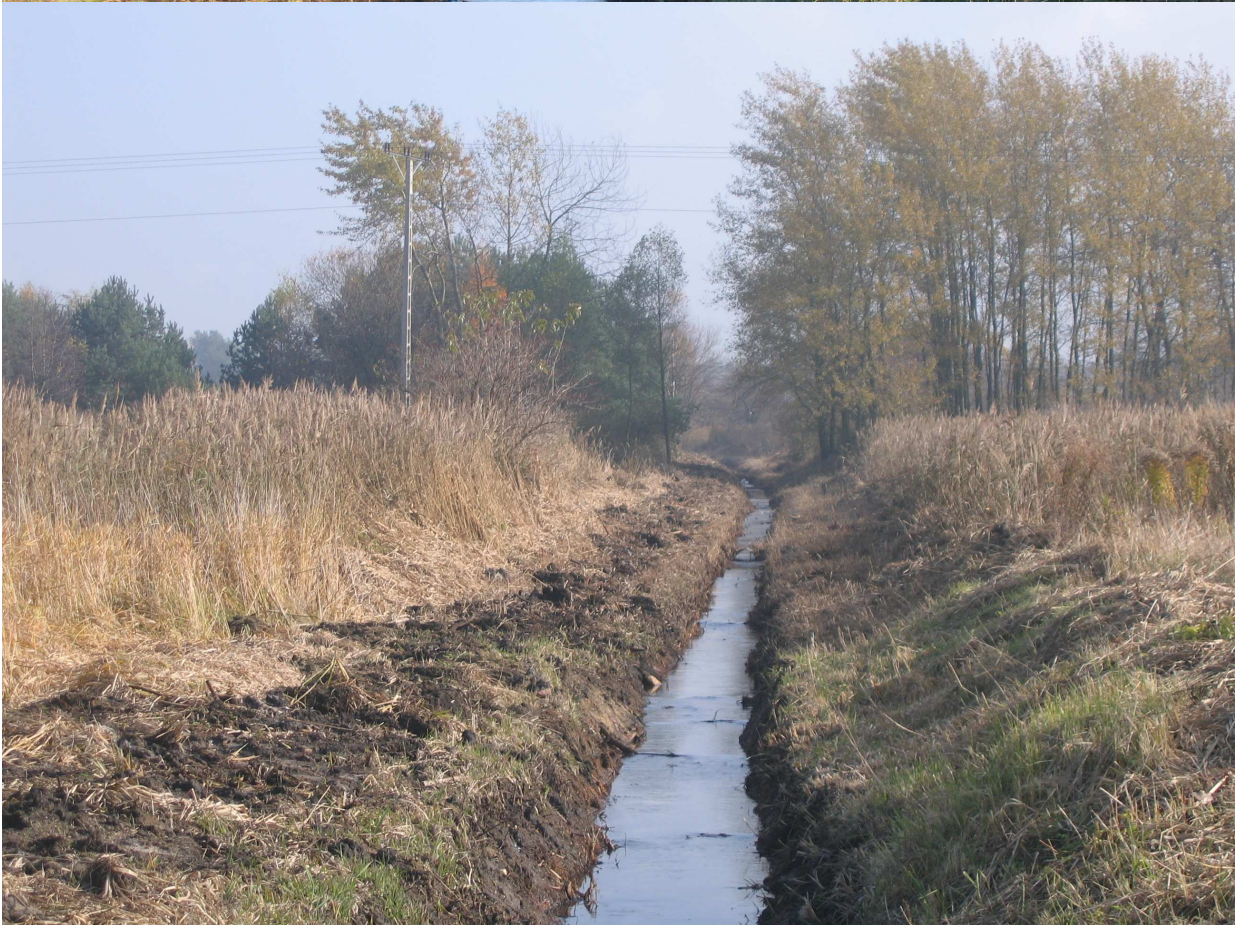
Odbudowano Potok Ożarówicki.
