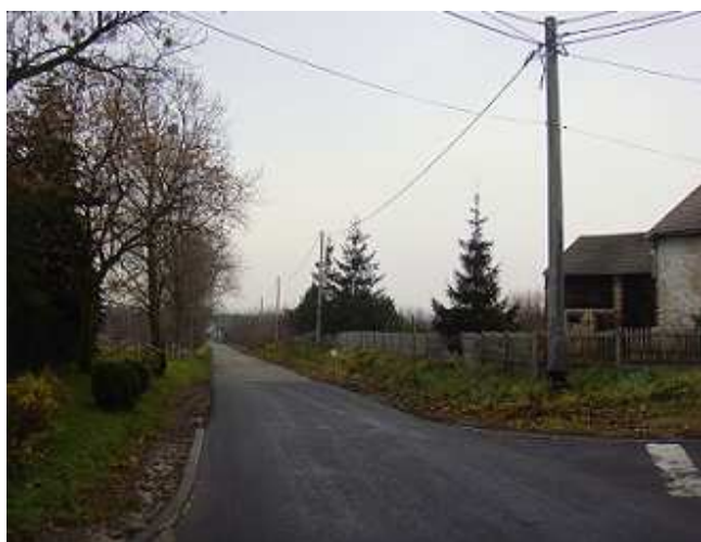
Budowa sieci oświetleniowej przy ul. Sobieskiego i Wyzwolenia.
