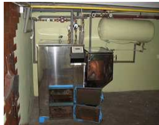
Nowoczesny, ekologiczny, bezpieczny kocioł co. w tej samej kotłowni.
