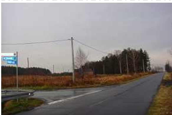
Trwa budowa sieci oświetlenia ulicznego przy ul. Królewiec.
